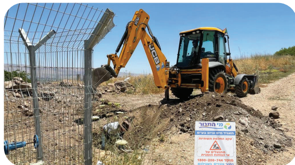
חיבור שכונת יובלים בקרית שמונה לתשתית המים הציבורית
